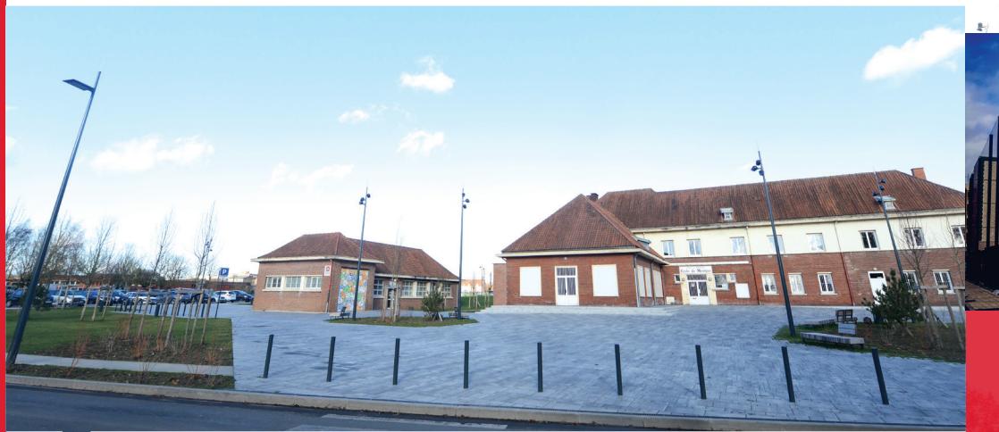
Aménagement du parvis sud du pôle gare avec la réfection totale du parvis et la création d'un cheminement piétonnier pour rejoindre la passerelle, la réalisation d'un parking provisoire de 100 places face à l'école de musique
